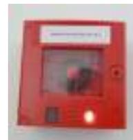
A botoneira localizada na sala de assistentes operacionais, na entrada do do Bloco B, permite desligar o abastecimento de energia elétrica do Bloco B.
