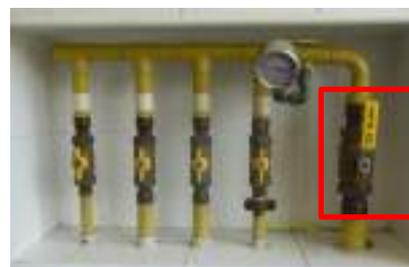
A válvula localizada na cozinha, permite ligar e desligar o abastecimento de gás combustível na cozinha, Bloco C
