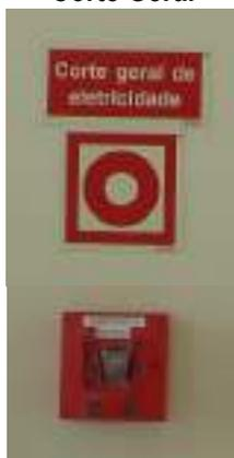
A botoneira localizada na entrada principal do Bloco A, permite desligar o abastecimento geral de energia elétrica.
