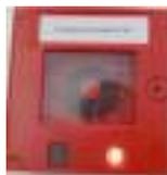
A botoneira localizada na do Bloco D, permite desligar o abastecimento de energia elétrica do Bloco D.
