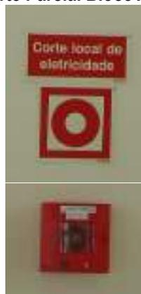
A botoneira localizada na entrada principal do Bloco A, permite desligar o abastecimento de energia elétrica do Bloco A.
