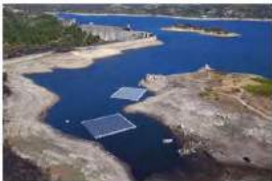
Figura 4A – Painéis fotovoltaicos flutuantes no espelho de água da albufeira do Alto Rabagão.
